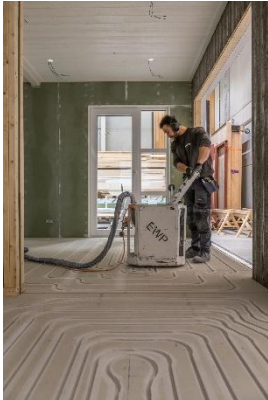
Voorbeeld ingeslepen vloerverwarming
